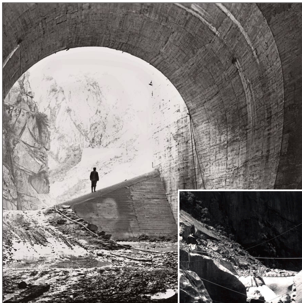
Nov.1957- Estructura de salida del túnel del aliviadero
